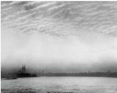
1) Blick auf Köln bei Sonnenaufgang, 1938
