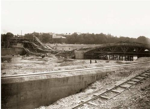
13) Beim Bau der Corneliusbrücke über die Isar stürzte am 26. August 1902 einer der Brückenbogen ein.
